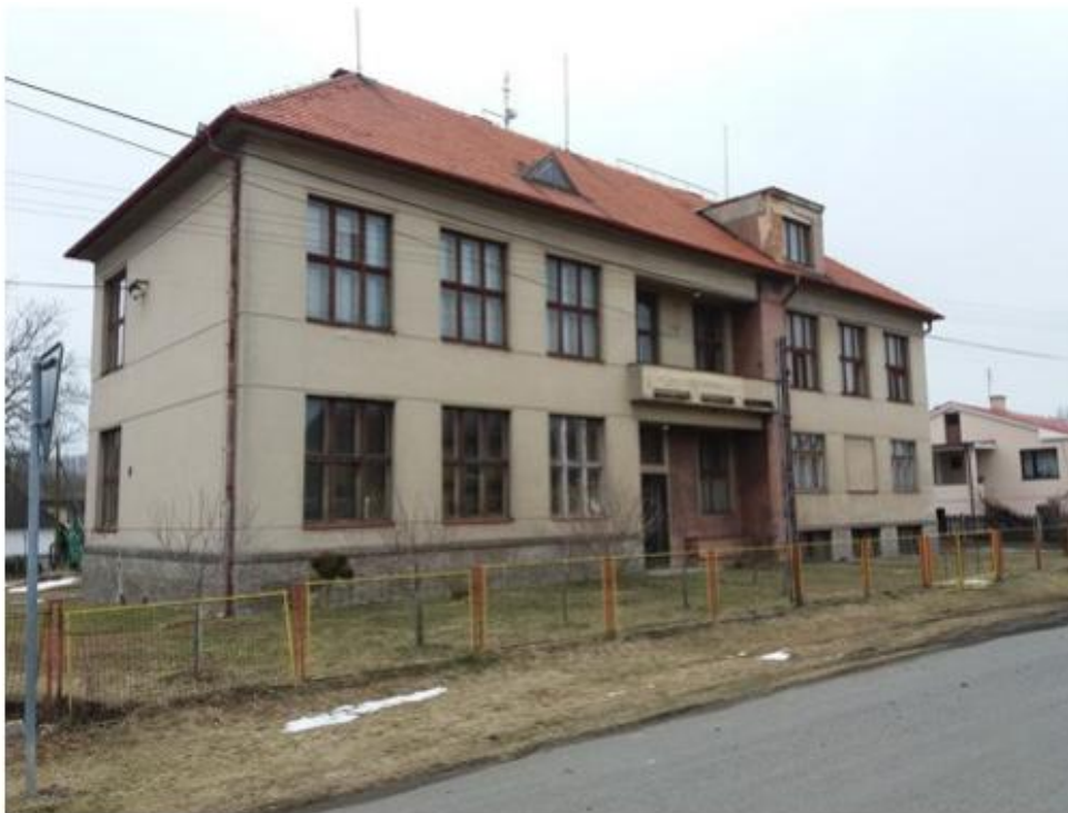
Bývalá základní škola ve Třtici.
